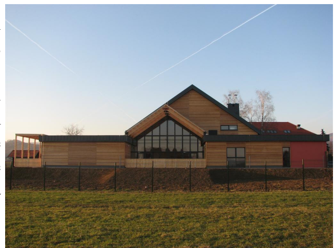
Na novo zgrajen vrtec v Šentrupertu.
